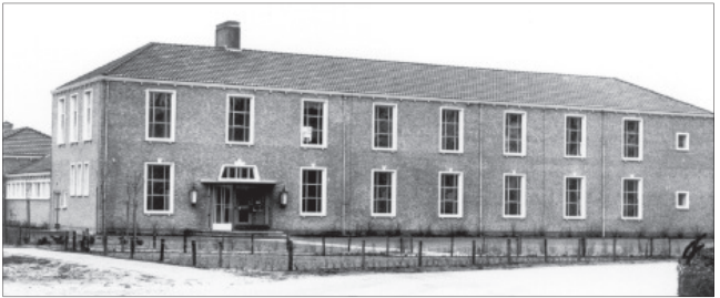
Nieuwbouw (1959) R.K. Huishoudschool Twello, foto L. Gruntjes
