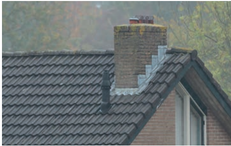
Zogenoemde loketten aan de schoorsteen
