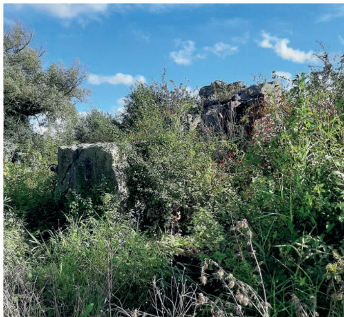
De betonnen restanten van wat eens de fundering was van de pilaar die de grote draaischijf ondersteunde. Dit is vlak aan de IJsseloever.
