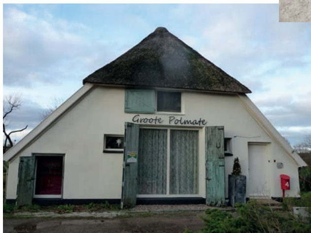
De Polmate na de restauratie
