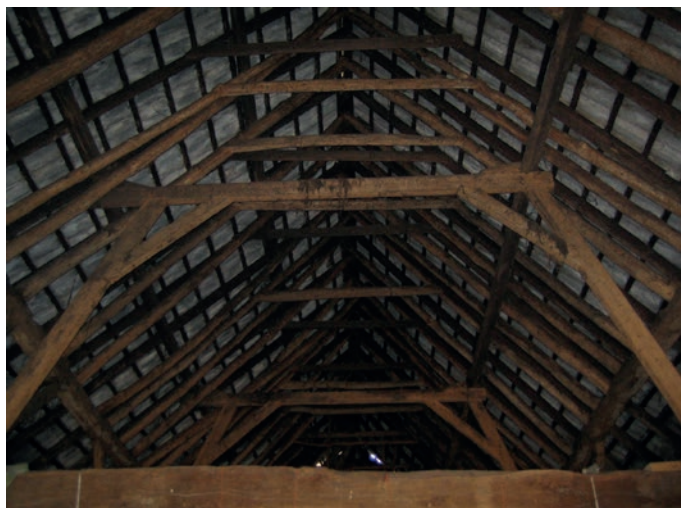
De kapconstructie van boerderij 'het Noetelsvelt'
