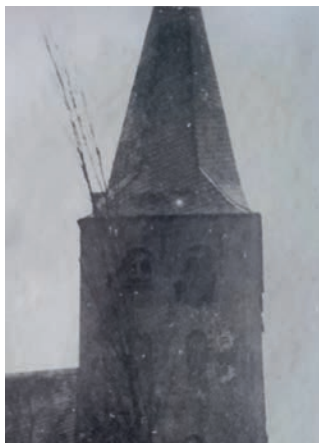
De toren in 1943 met gat voor het verwijderen van de klokken, foto Johannes Gijsbert Stenfert
