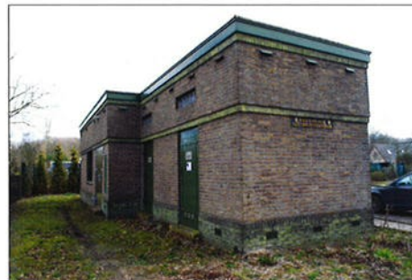
Een van de grote trafohuisjes in de gemeente Voorst (Twello, Terwoldseweg)
