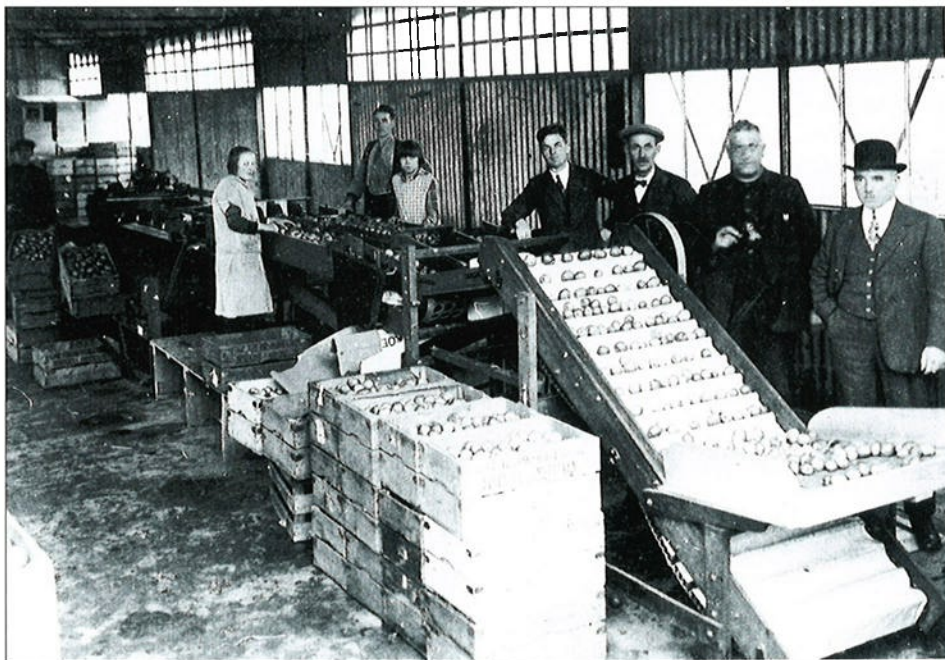
De sorteermachine die in 1947 in gebruik was, foto ter gelegenheid van het 40-jarig bestaan.
