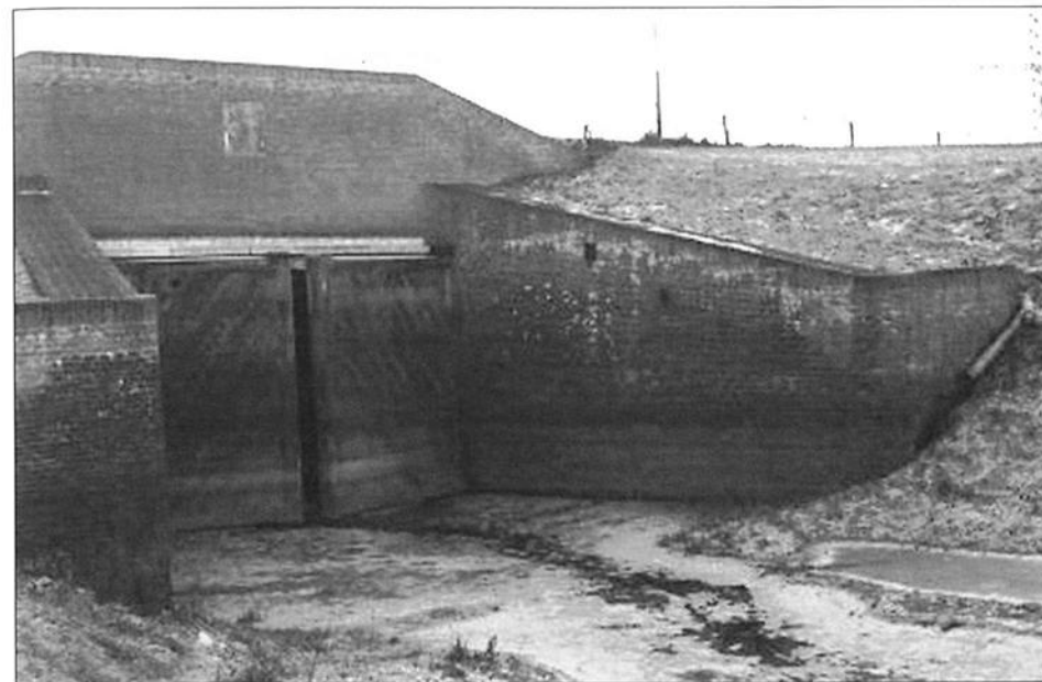
Duikersluis in de Veluwe Bandijk (de 'dwarsdijk' ten zuid-oosten van Hulsbergen), foto J. Lubberts
