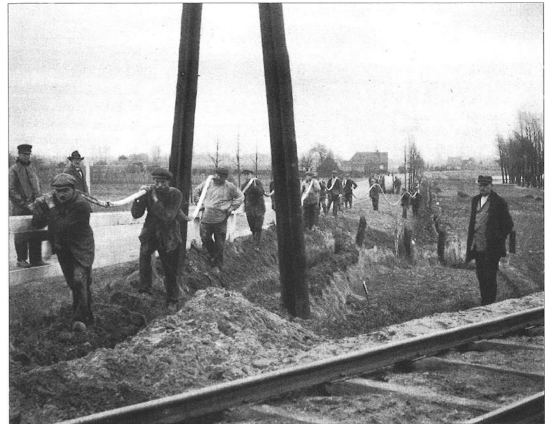
In 1928 wordt een elektriciteitskabel gelegd van Apeldoorn naar Zutphen. Op de foto zijn de mensen aan het werk bij de spoorwegovergang tussen Empe en Zutphen.
