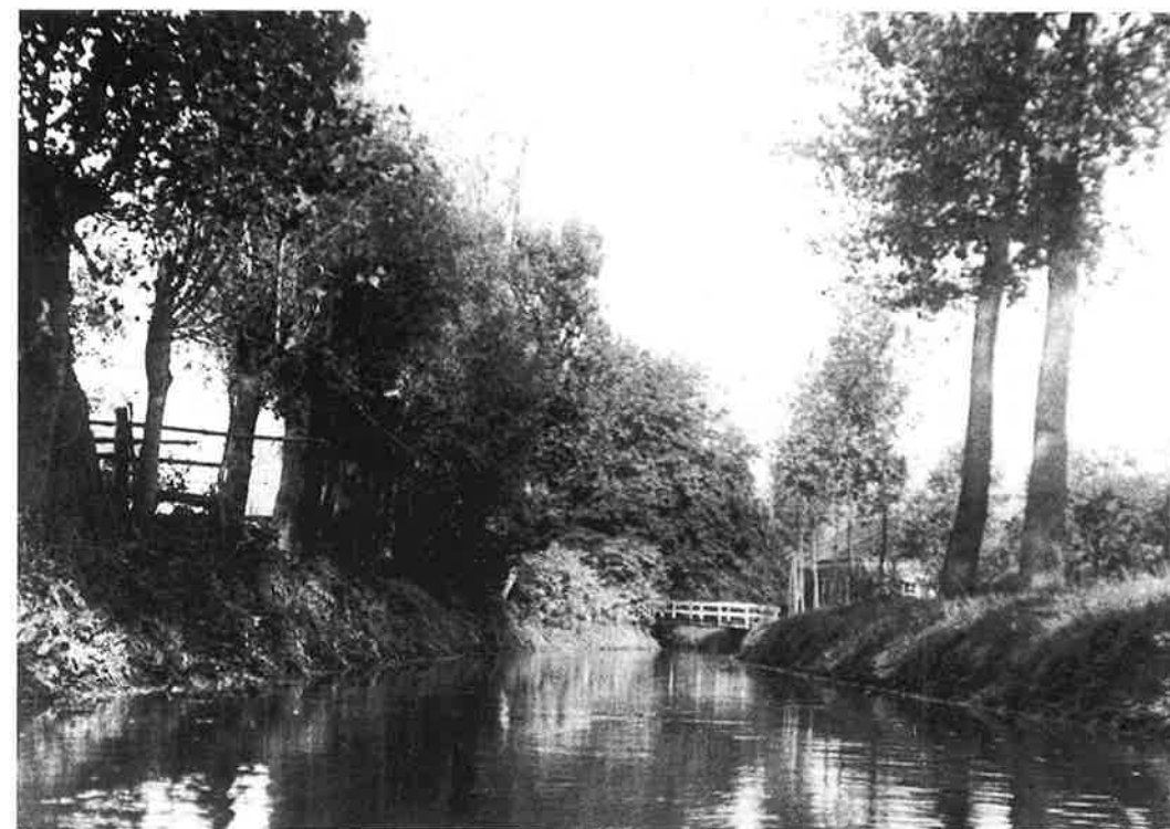
De brug over de Grote Wetering.
