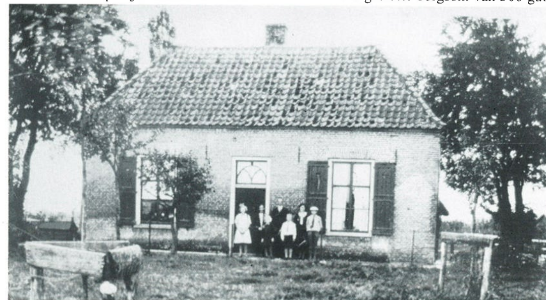
Meester Vink was in 1842 eigenaar van de Peppelenkamp, een stuk bouwland aan de Wijkseweg, waarop een nieuw huis werd gebouwd. Deze foto toont de Peppelenkamp in circa 1930 met de toenmalige bewoners: de familie De Weerd. De boerderij is ondertussen vervangen door een bungalow.
