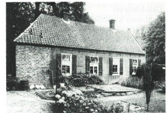
De voorgevel van het v.m. tolhuis in 1993 (Foto L. Sevenster)
