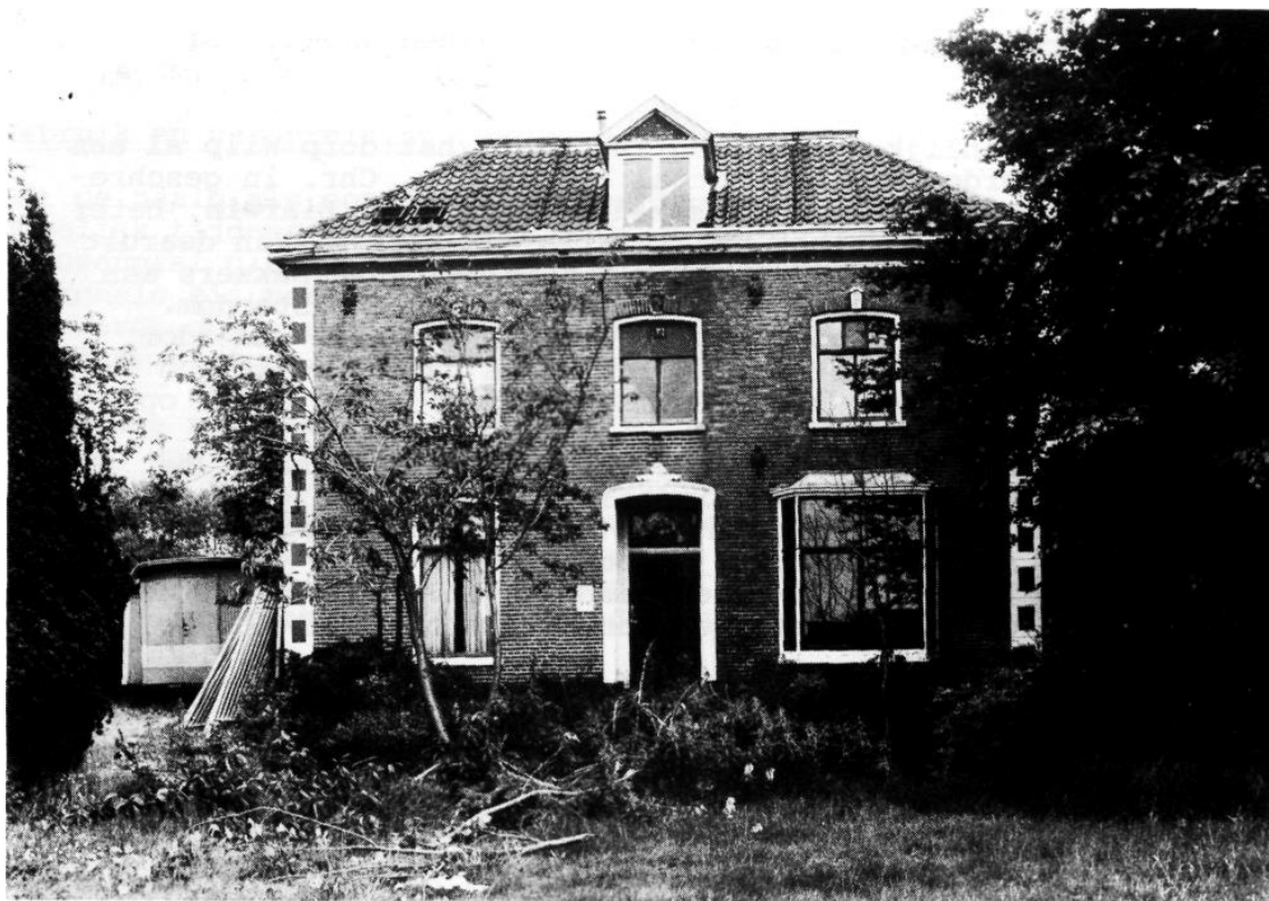
De villa van de fam. Linthorst die zal worden afgebroken in 1991. (foto L. Sevenster)
