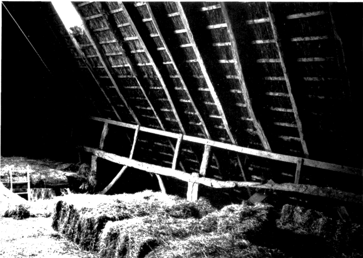
Verhoogde kapconstructie noordzijde.
